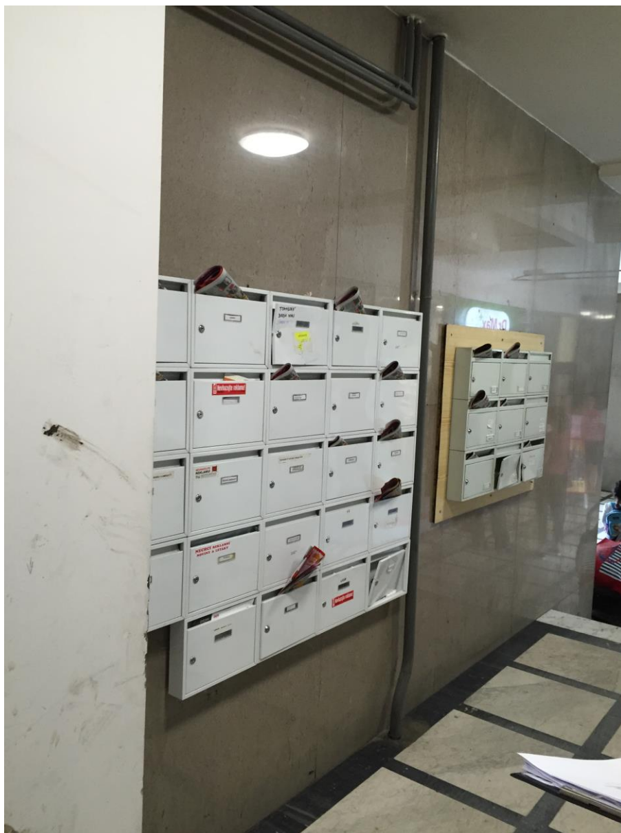
Stávající schránky umístěné v místnosti č. 1.02 za vyrovnávacím schodištěm. Schránky budou nahrazené novými, nerezovými schránkami, vestavěnými do zdi.
