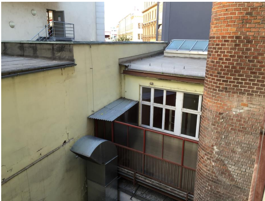
Pohled na pravý dvorek – výfuk VZT provozu Quick, stávající zděný komín – dojde k přečištění a vyspravení konstrukce komínu.
