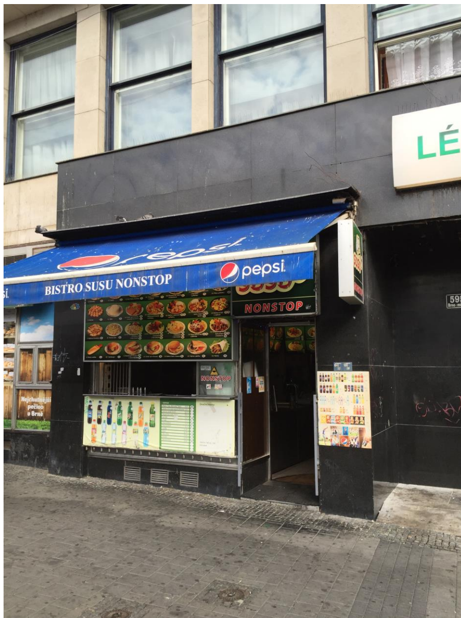
Pohled na levý provoz asijského bistra. Tento provoz bude nahrazen kancelářským prostorem. Stávající prosklený parter je součástí centrálního vstupního portálu, který projde repasí včetně výplní otvorů a původních větracích mřížek. Budou odstraněné veškeré druhotné konstrukce, stříšky a reklamy.
