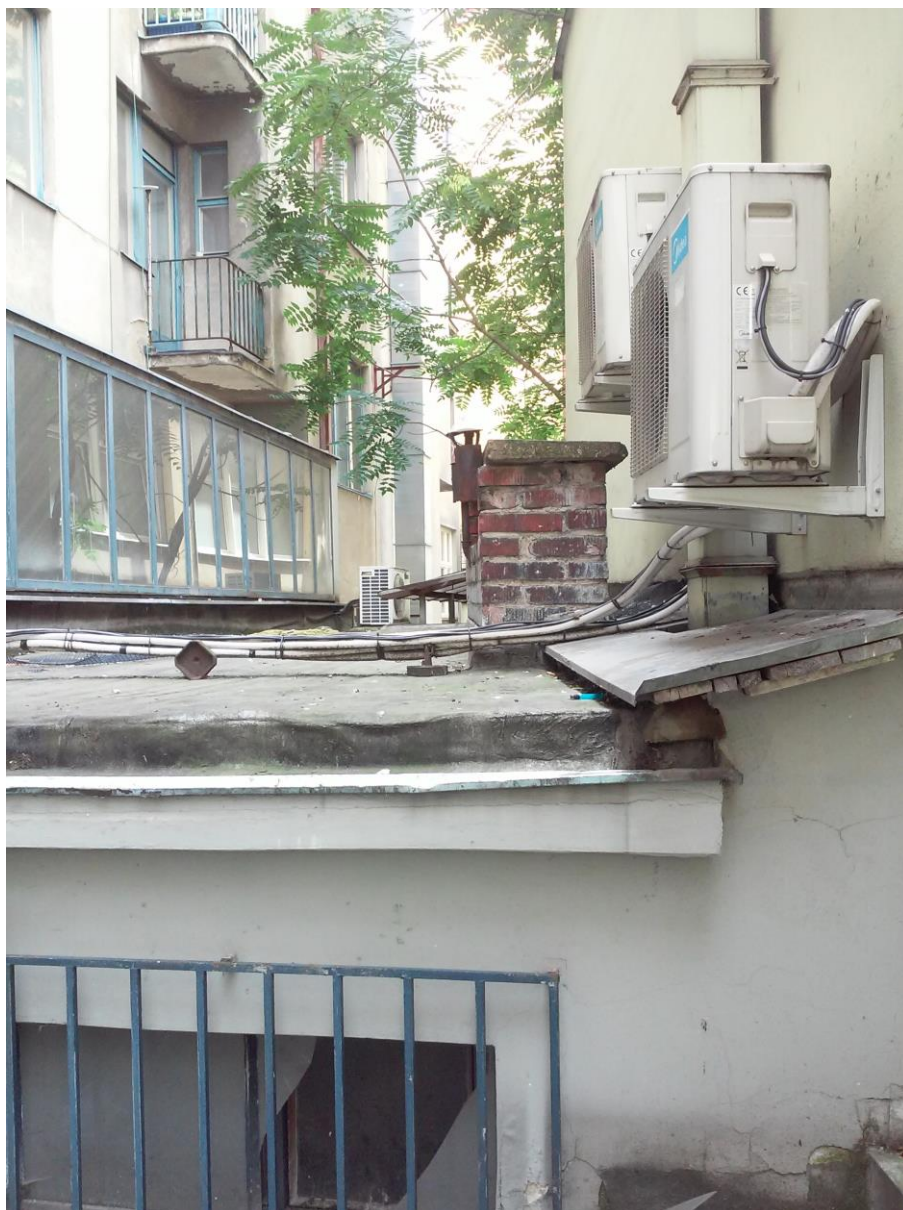
Pohled na střechu nad stávajícím provozem lékárny – zasklení světlíku, stávající mříže oken projdou odbornou repasí. Skladba střechy bude mít novou skladbou se zateplením. Na obrázku jsou klimatizační jednotky provozu lékárny. Jednotky budou odstraněné a nahrazené novými jednotkami pro jednotlivé provozy.
