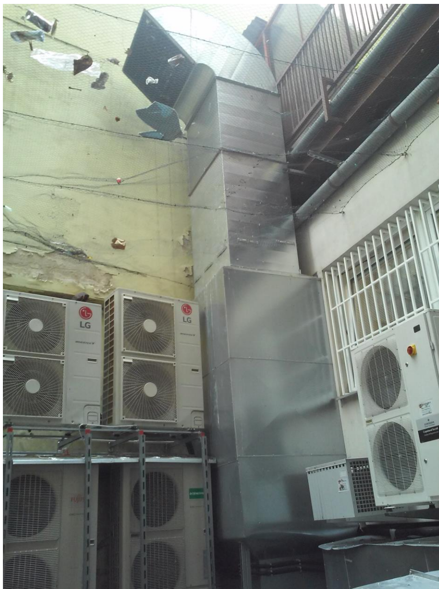
Pohled na pravý dvorek – vzduchotechnika (výfuk) a klimatizační jednotky provozu Quick. Stávající zasíťování dvorku bude odstraněné.
